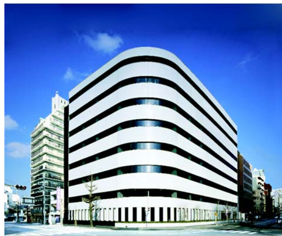
大阪中央データセンター
