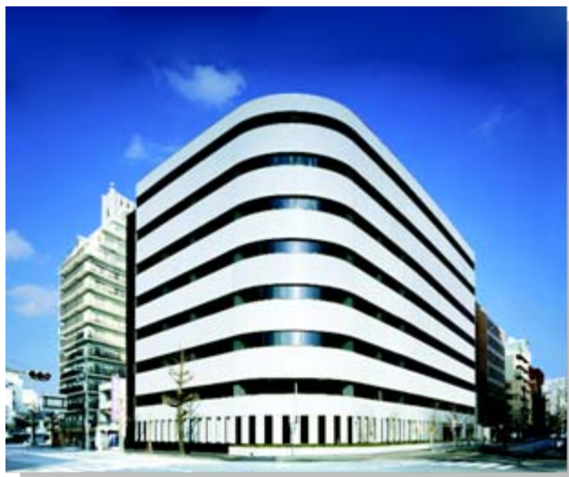
大阪中央データセンター
