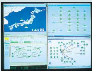
100インチマルチビジョン監視モニター
